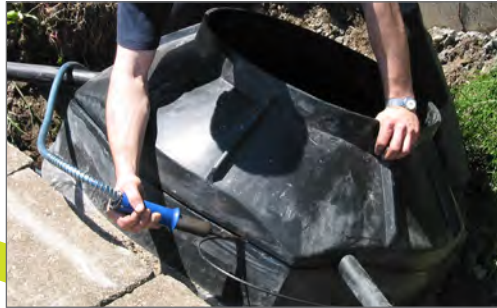
Trennen und wieder Verschweißen möglich
