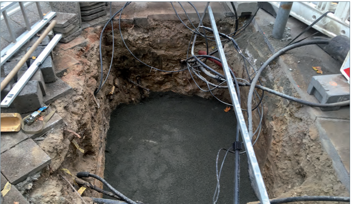
Abgebrochener Kabelschacht, einzubindende Kabel, Leerrohre
