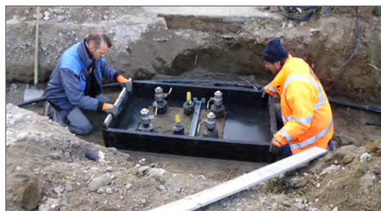
Fernwärmeschacht
