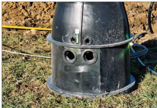
Rohranbindung an beliebiger Stelle mittels ROMOLD IS Dichtung
