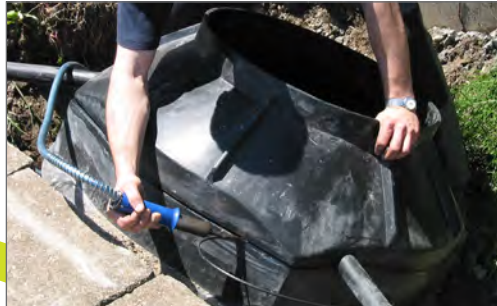
Trennen und wieder Verschweißen möglich
