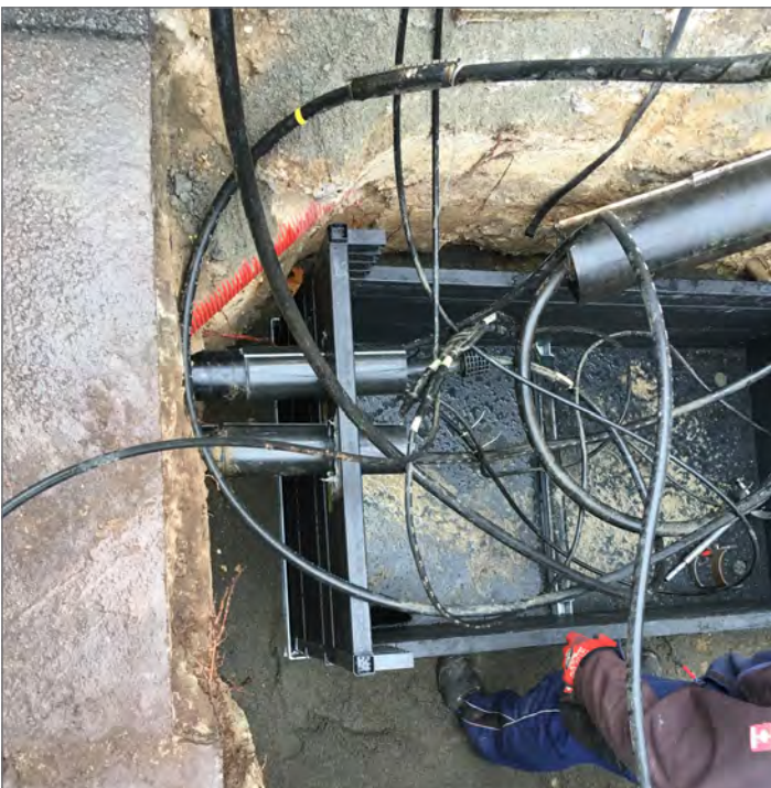
Der Kabelschacht ist auf der Baustelle einfach in der Höhe teilbar und auch die einzelnen Rahmen sind ohne Werkzeug zerleg- und wieder zusammenbaubar
