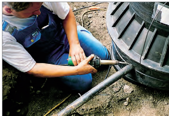
Energie AG Oberösterreich: Verschweißen der Elemente
