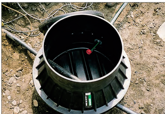
Energie AG Oberösterreich: Einblasen des zusätzlichen LWLs
