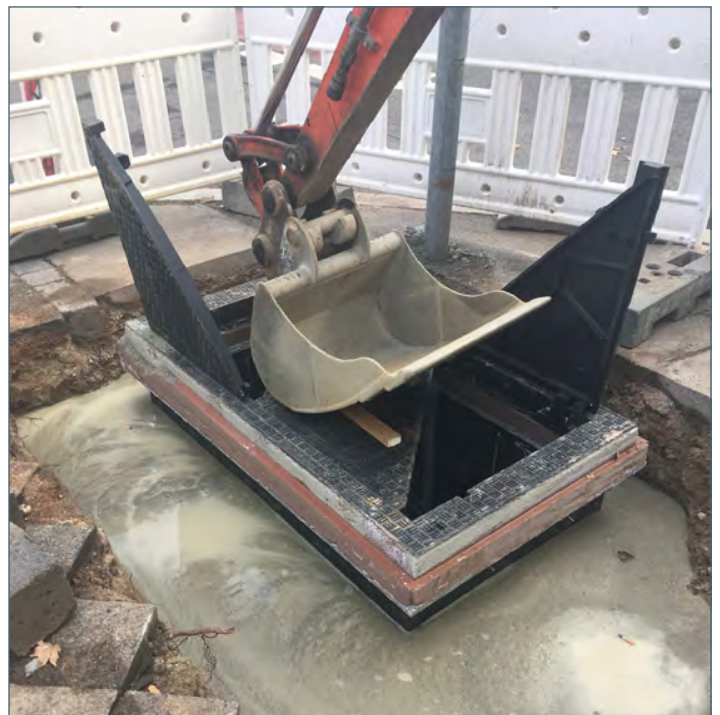
Einbau in Flüssigboden problemlos möglich (Auftriebssicherung durch Baggerschaufel)
