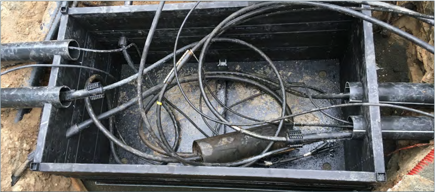
Einbindungen in unterschiedlichen Höhen und Winkeln bauseits realisierbar
