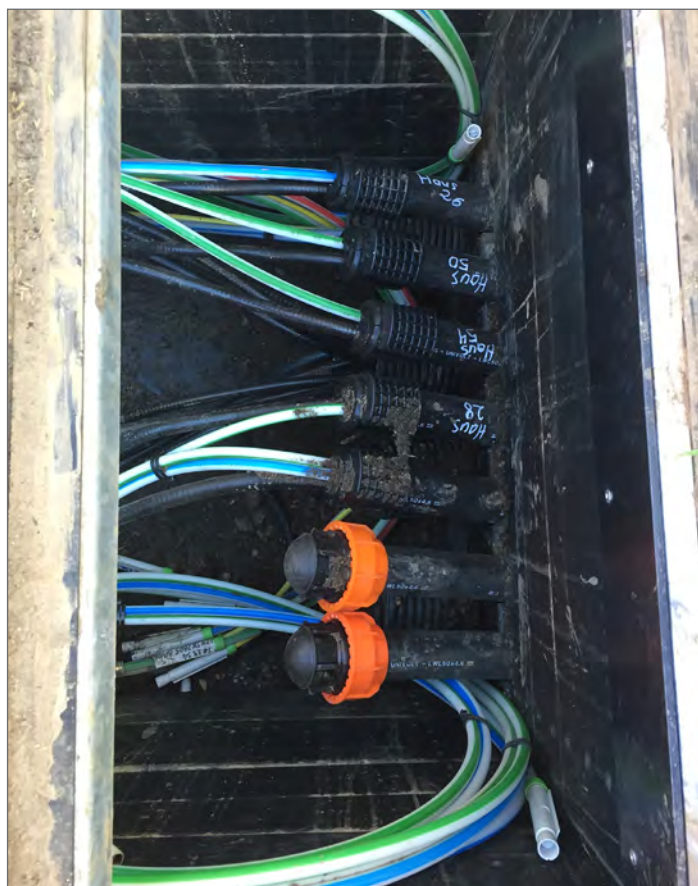
Eingebaute ROM-Box mit verschiedensten Kabelsträngen
