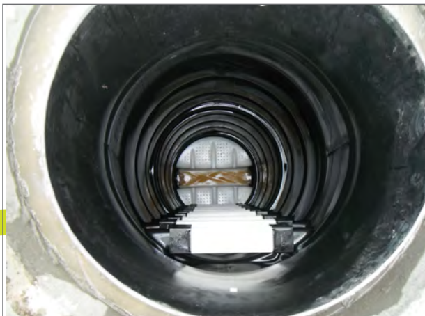
Neuer PE-Schacht DN 800 in korrodiertem Schacht DN 1000
