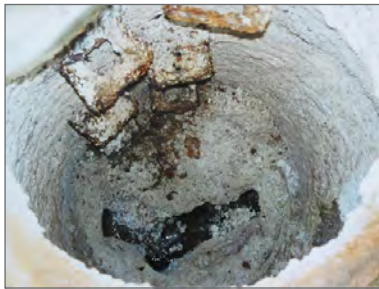
Ausgangssituation: korrodierter Betonschacht
