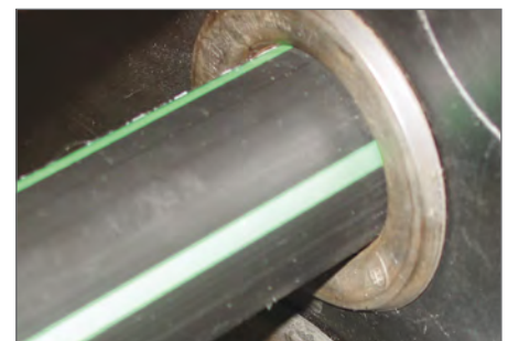
Rohranbindung mit Dichtung 0,5 bar wasserdicht
