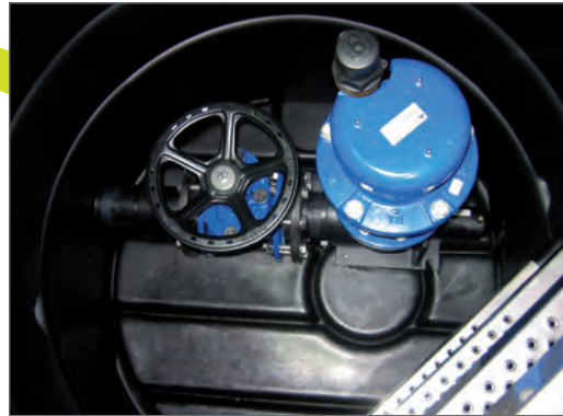
Be- und Entlüftungsschacht
