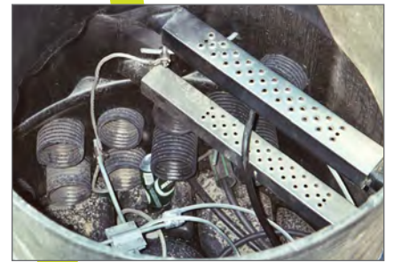
Steigstufen sind bei Bedarf (Kabeleinbau) leicht zu entfernen.
