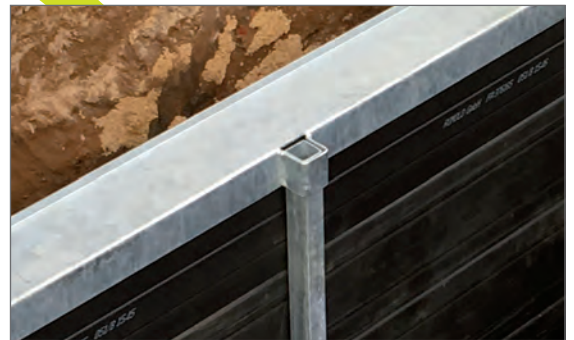
U-Rahmen einteiliges bzw. teleskopierbares Vertikalprofil
