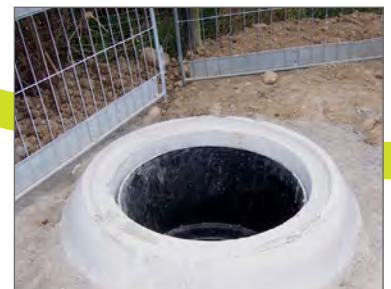
Lastentkoppelte Abdeckung.
