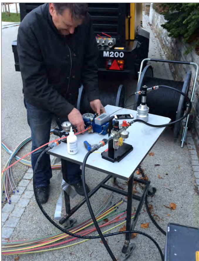
Glasfaser-Kabel werden eingeblasen.
