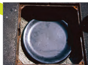
Dichtes Schachtabdeckungssystem mit getrennter Dicht- und Tragfunktion
