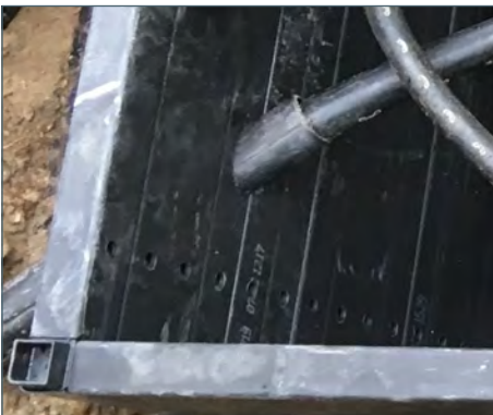
Schräge Anbohrung und Einbindung
