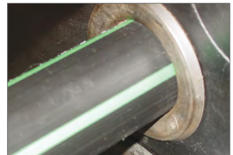
Rohranbindung mit Dichtung 0,5 bar wasserdicht
