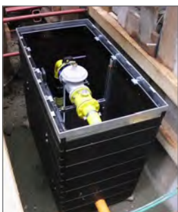
ROM-Box mit vorgefertigter Gas-Armaturengruppe
