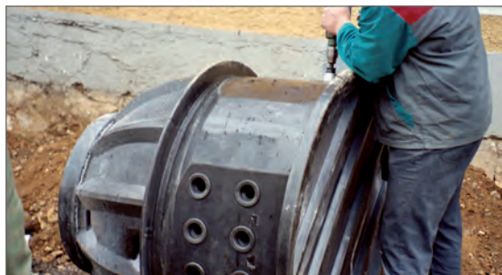
Rohranbindung und Dichtungsmontage vor Ort
