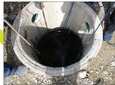
Neuen Boden in den Schacht ablassen
